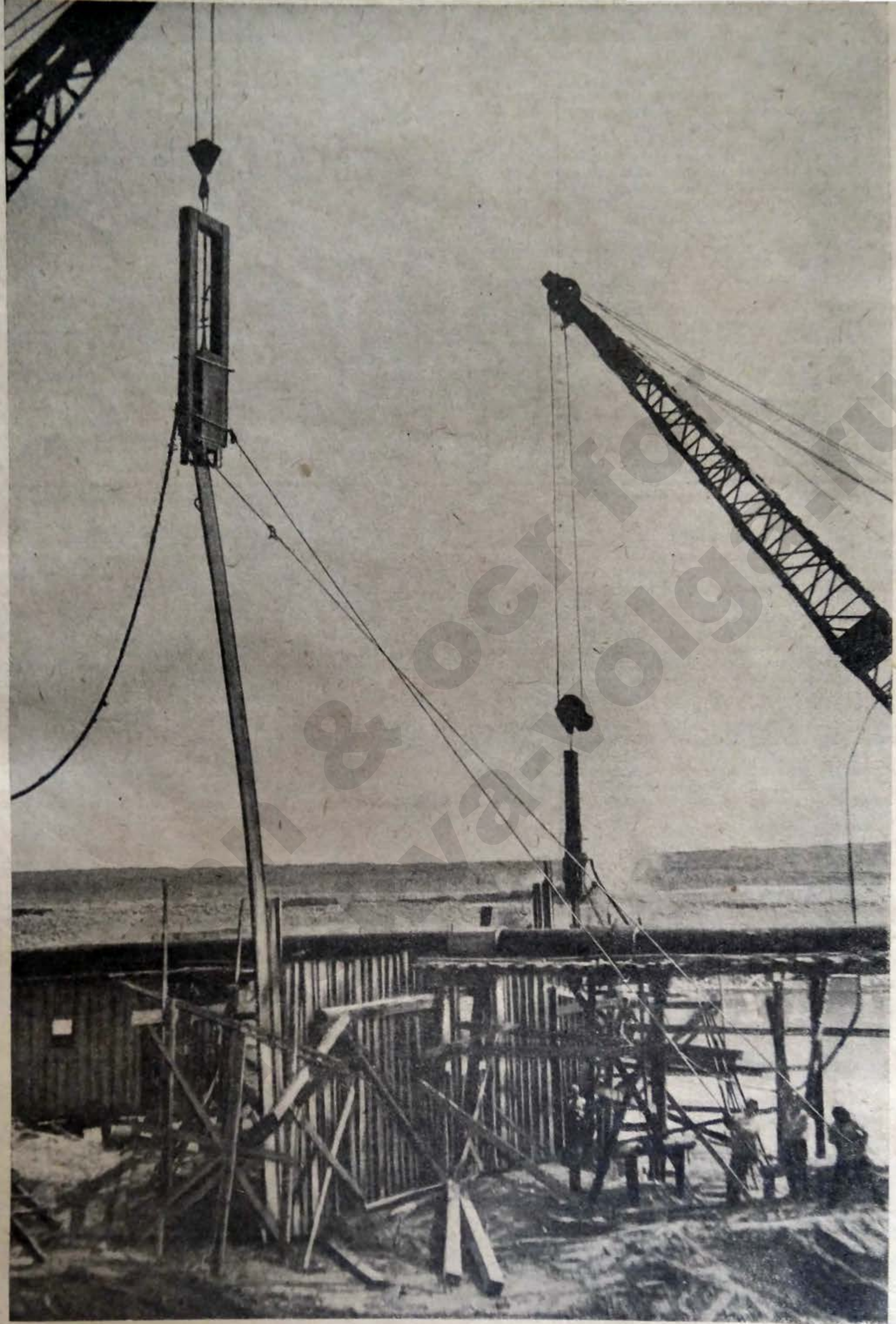
Забивка металлического шпунта на Волжской земляной плотине
