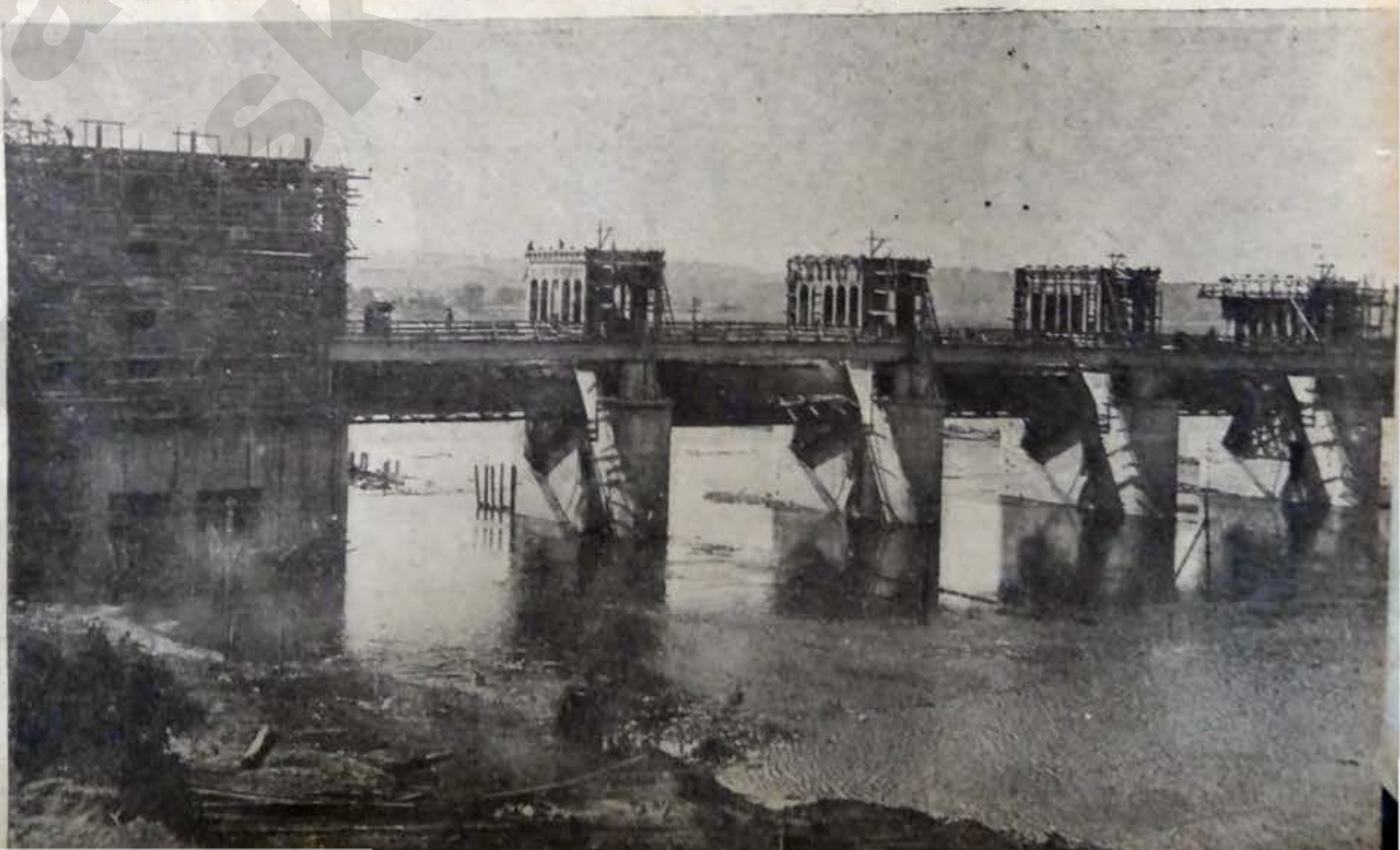
Строительство Карамышев- ской плотины на Москва- реке
