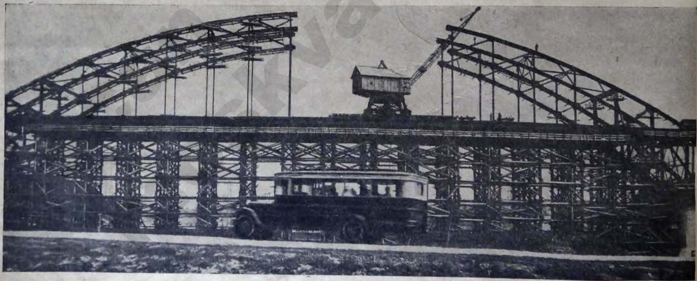
Сборка ферм моста через канал на Ленинградском шоссе
