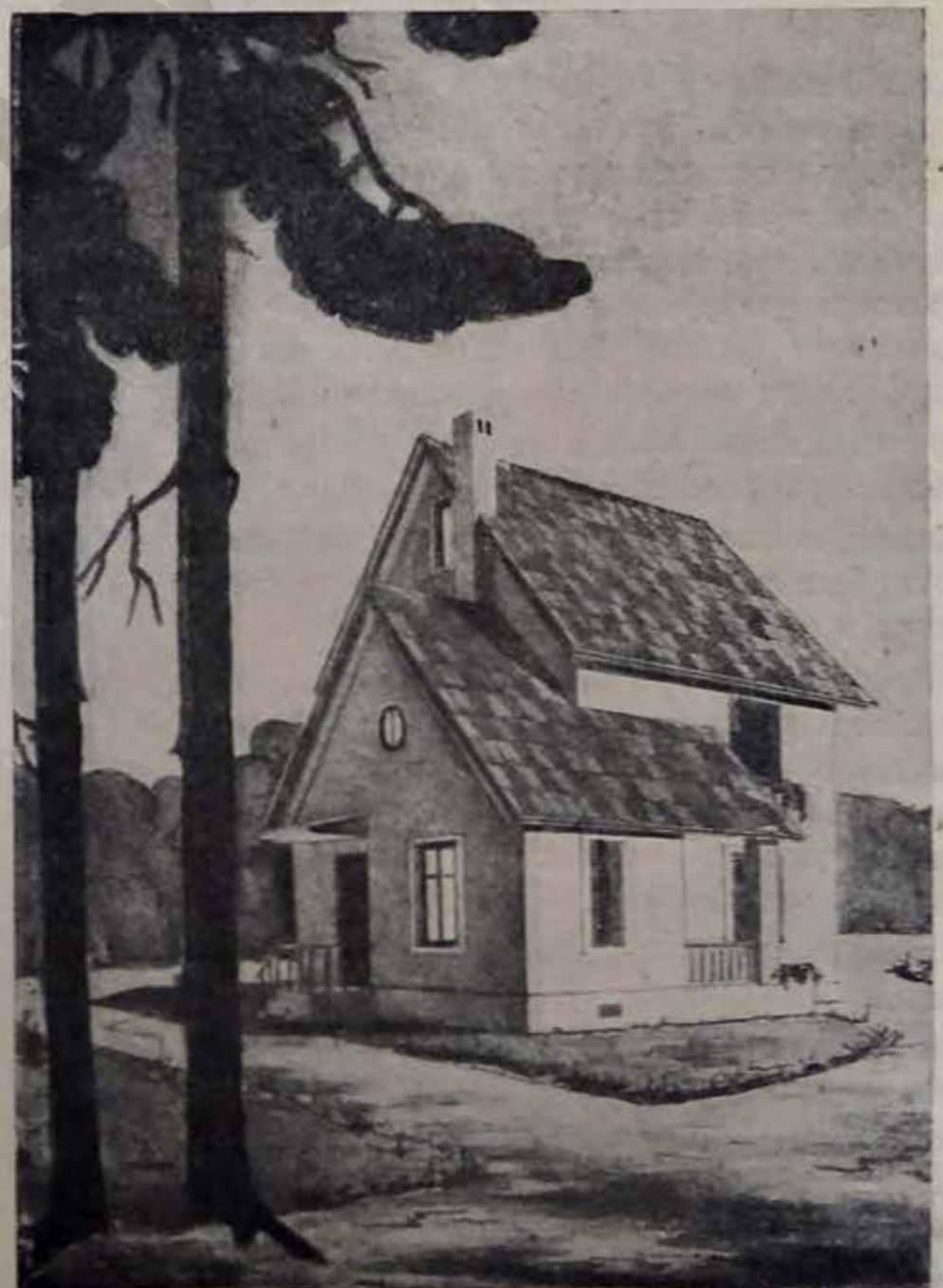
Дом техника (Водопроводный канал)
