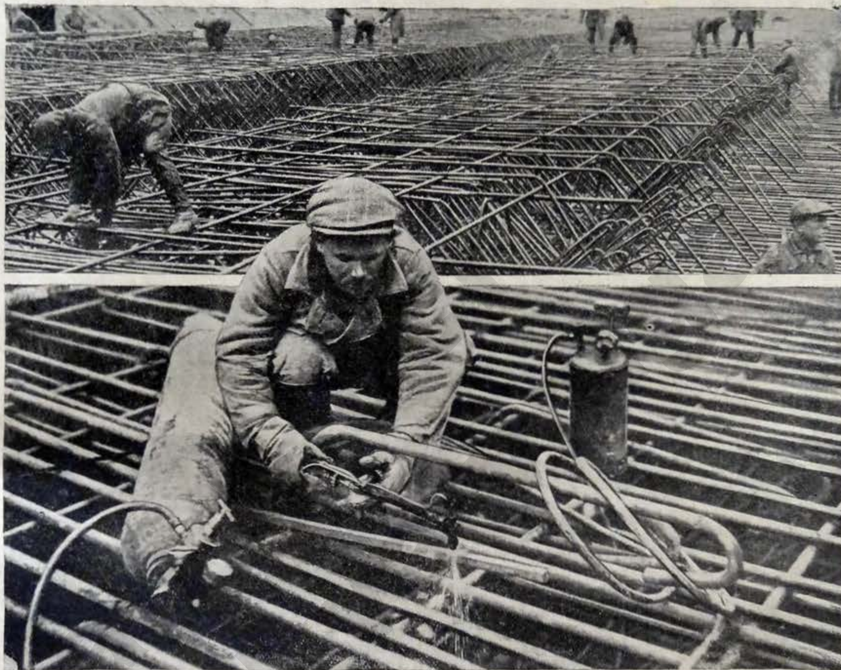
Постройка трубы для пропуска под каналом реки Сестры
