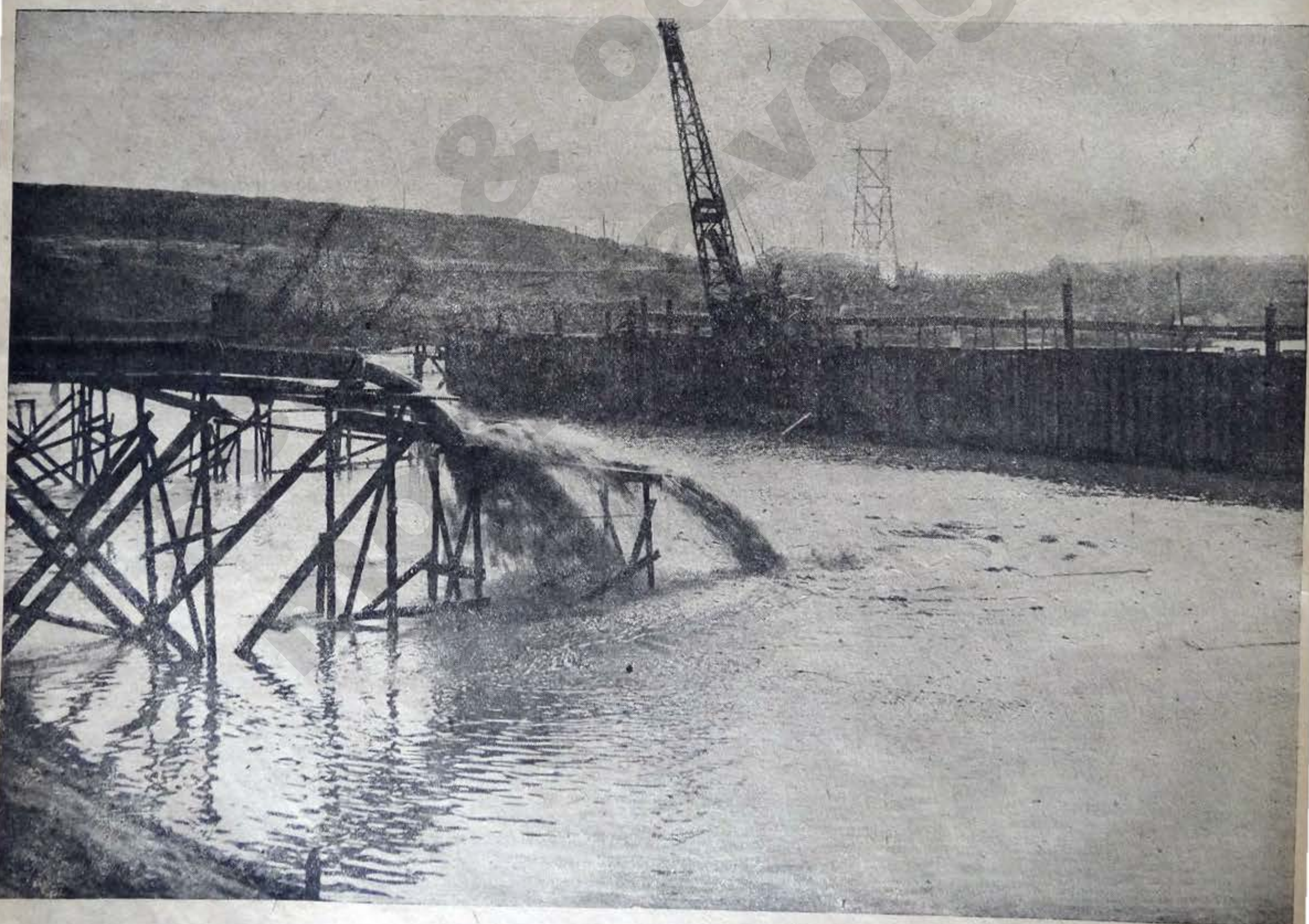
Гидромеханический намыв Волжской земляной плотины
