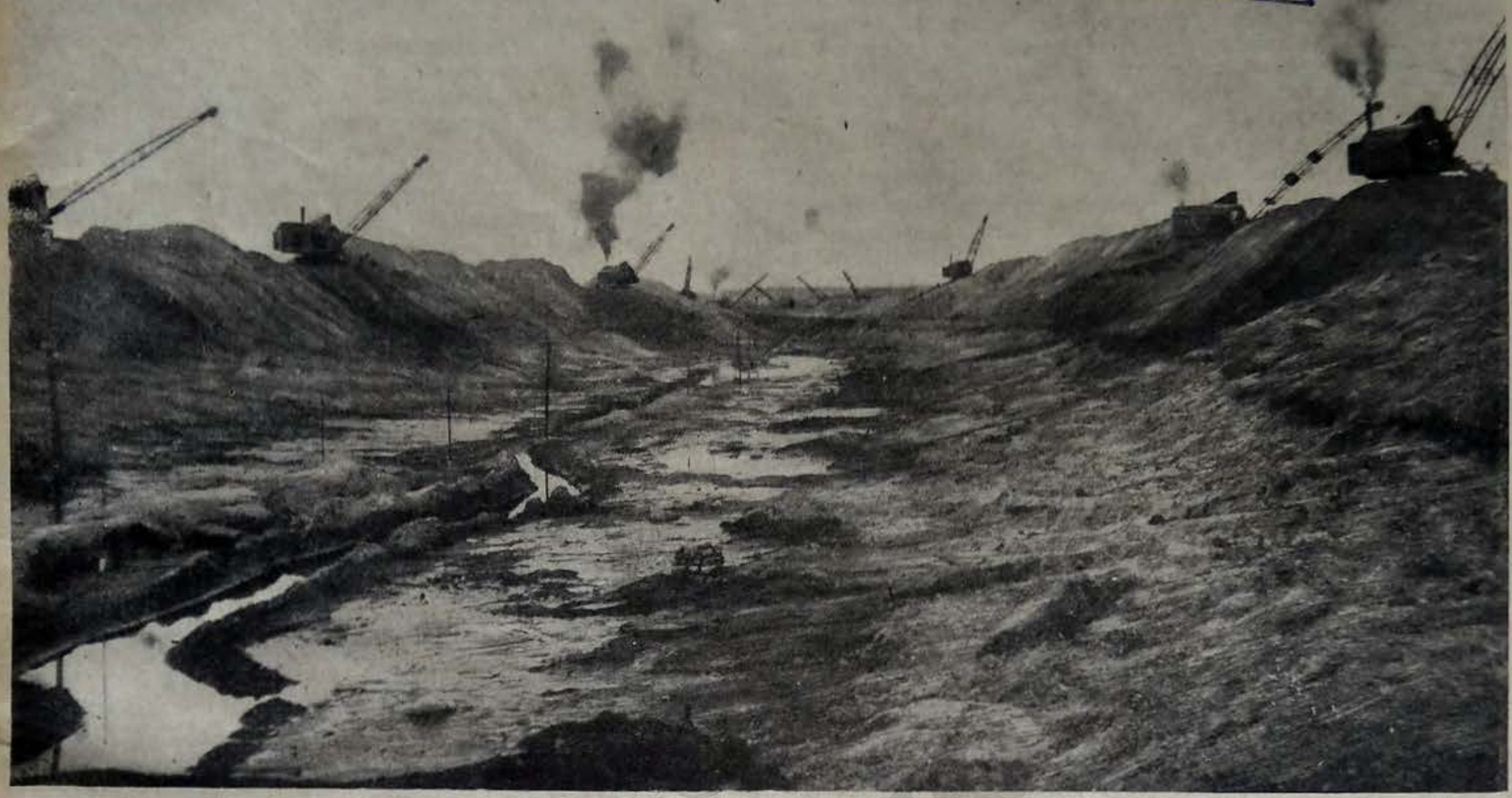
Эксплуататорные работы на девятом километре канала
