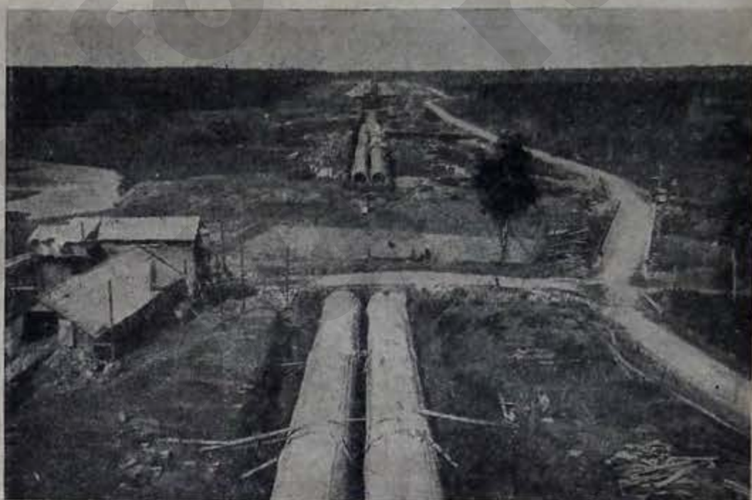
Закрытые водоводы Водопроводного канала
