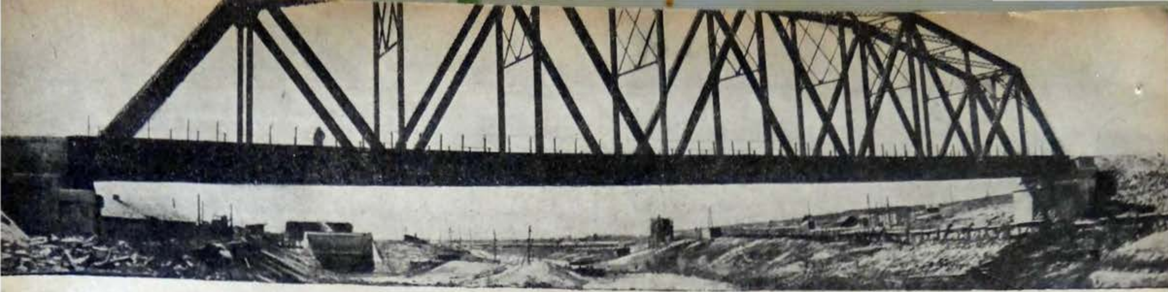
Общий вид моста через реку Сестру
