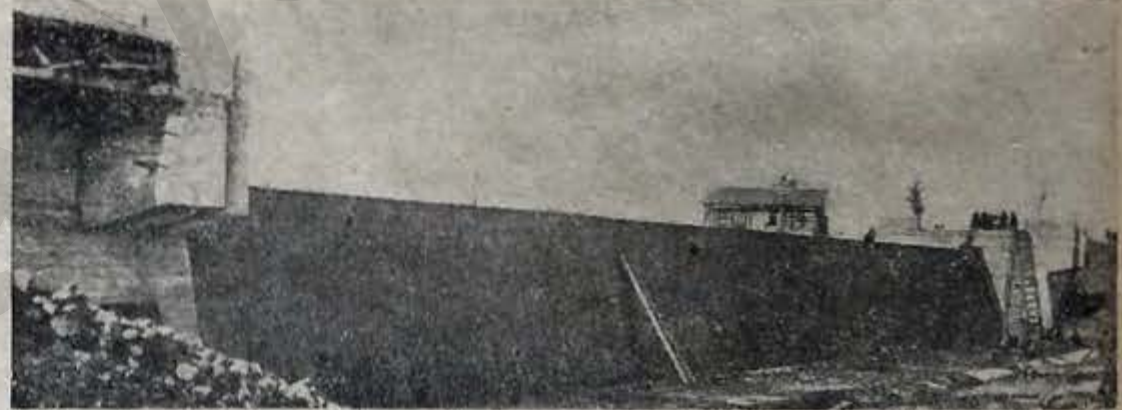
Вид на камерные стены волжского шлюза во время бетонирования смежных секций
