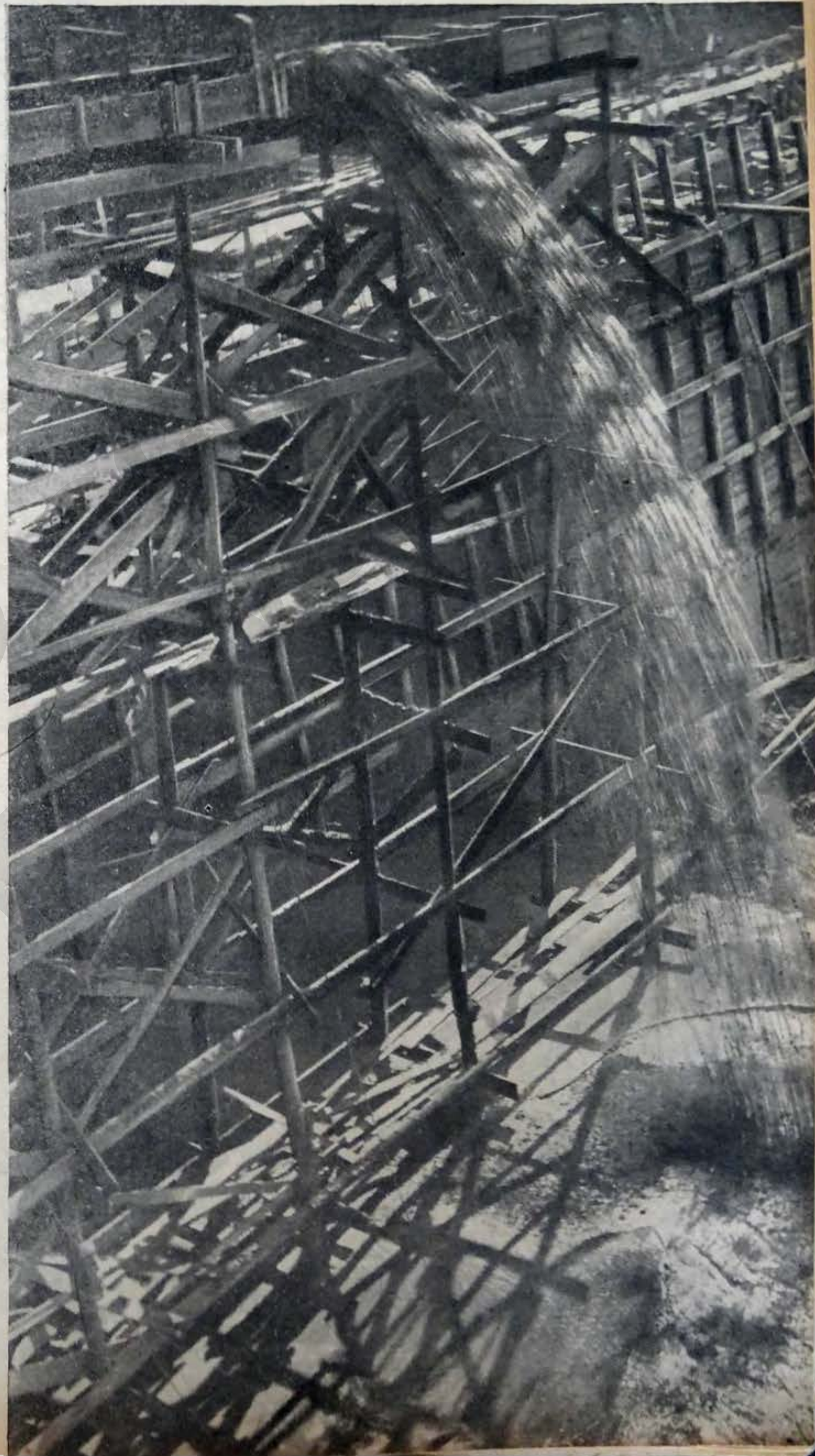
Гидромеханическая засыпка пазух шлюза № 7
